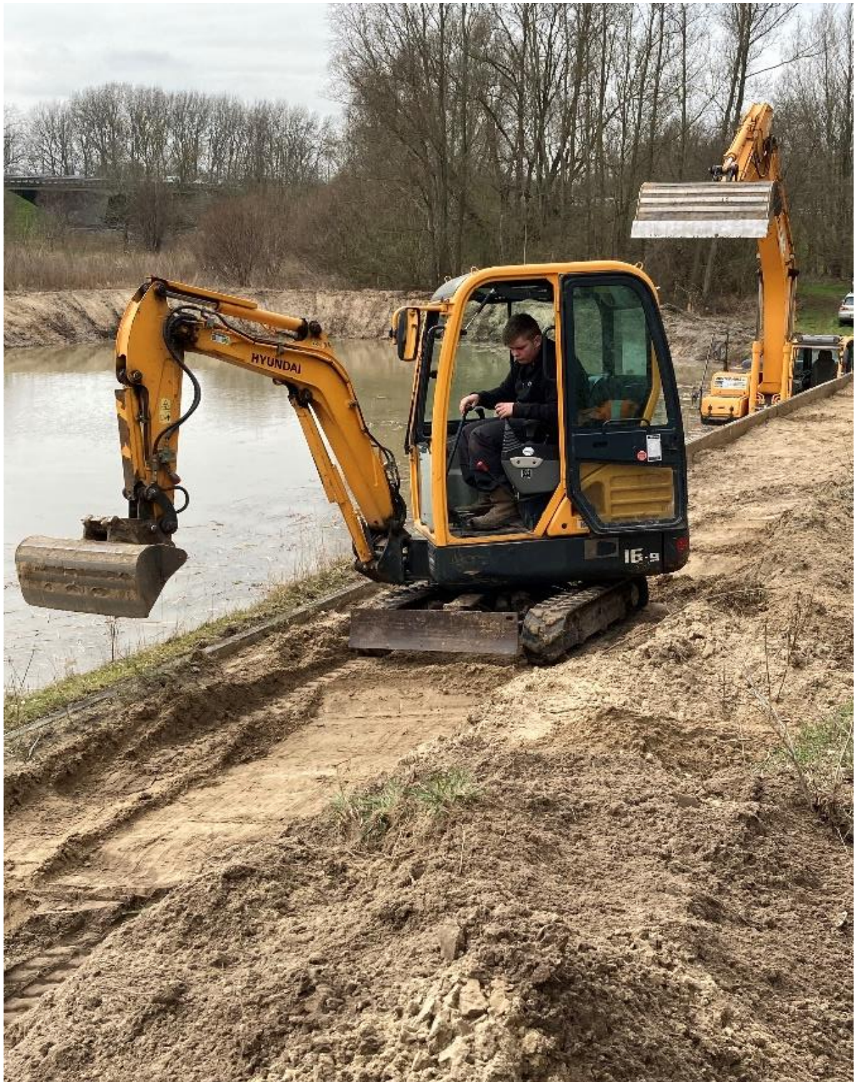
Volop graafwerkzaamheden bij de wand op Tweeloo
