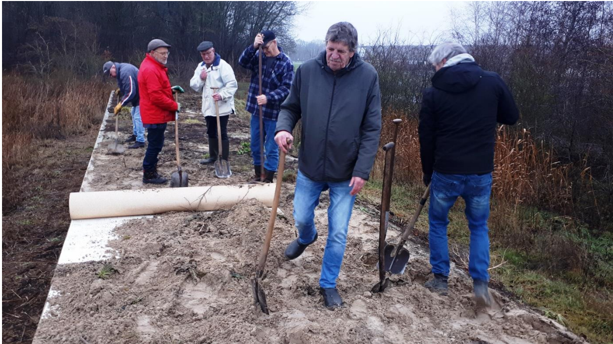
Aanbrengen van het zeil boven op de wand
