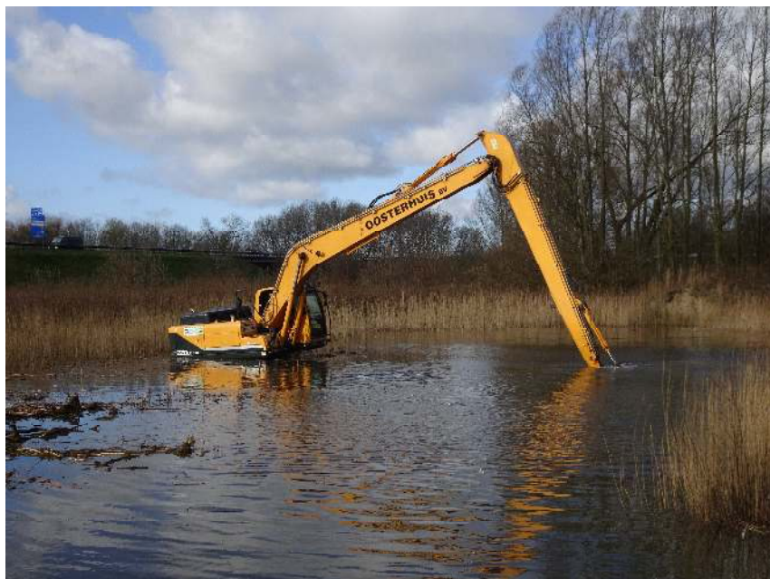
Uitbaggeren van de vijver
